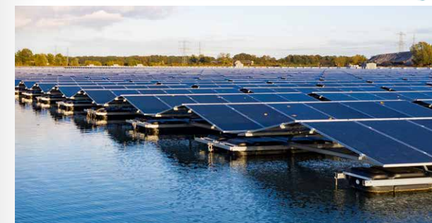
Fig. 6.2: Drijvende zonnepanelen laten relatief weinig licht door
